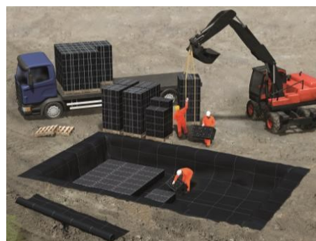
Obrázek 9: Umístění prvků vsakovací galerie
