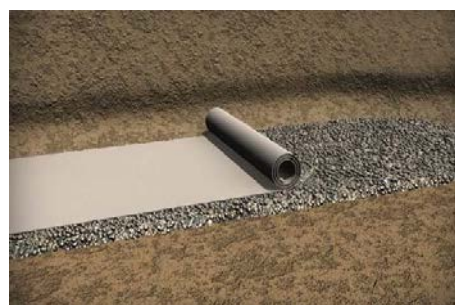
Obrázek 8: Pokládka geotextilie
