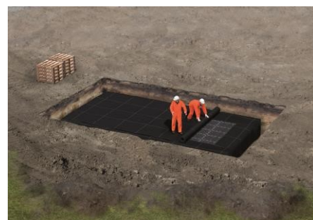
Obrázek 13: Zakrytí geotextilií
