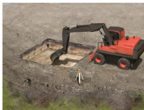
Obrázek 6: Kopání výkopu
