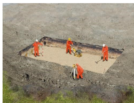
Obrázek 7: Příprava vyrovnaného základu
