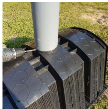
10. vyvrtejte otvor na zadní straně
