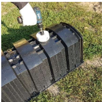
10. vyvrtejte otvor na zadní straně
